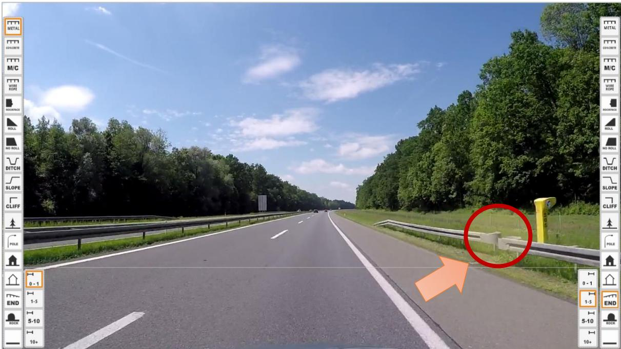
**Slika 22. Primjer opasnog mesta s prekidom u zaštitnoj odbojnoj ogradi**
