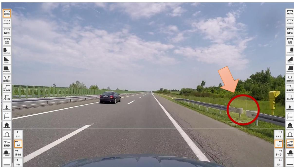
**Slika 15. Primjer opasnog mjesta s prekidom u zaštitnoj odbojnoj ogradi**
