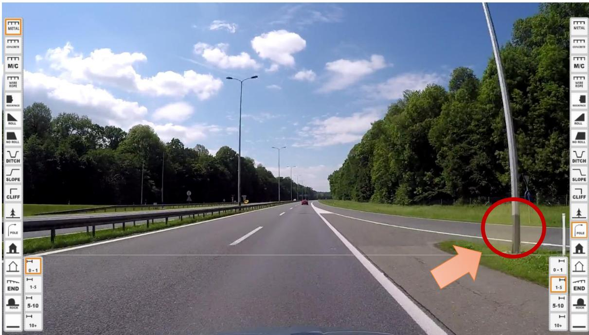
**Slika 20. Primjer opasnog mjesta s nezaštićenim stupom javne rasvjete na desnoj strani ceste, bez postavljene zaštitne odbojne ograde**
