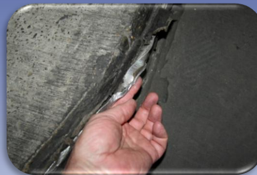
Drugi detalj negativnog primjera – oštećeni lim na rubnjacima
