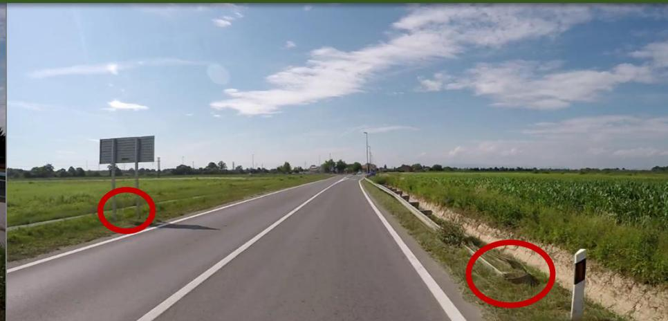
**ODGOVOR: Nezaštićeni opasni završni elementi odbojnih ograda, nezaštićeni stupovi vertikalne prometne signalizacije, opasni visoki nasipi, opasni odvodni kanali sa betonskim prijelazima uz cestu...**
