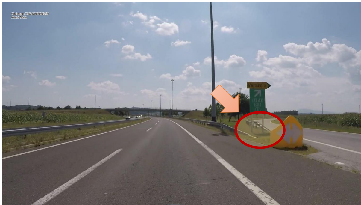
Slika 28. Primjer opasnog mjesta s nezaštićenim početkom metalnih zaštitnih odbojnih ograda na desnoj strani ceste u vrhu razdjelnog otoka traka za izlivanje prometnog toka
