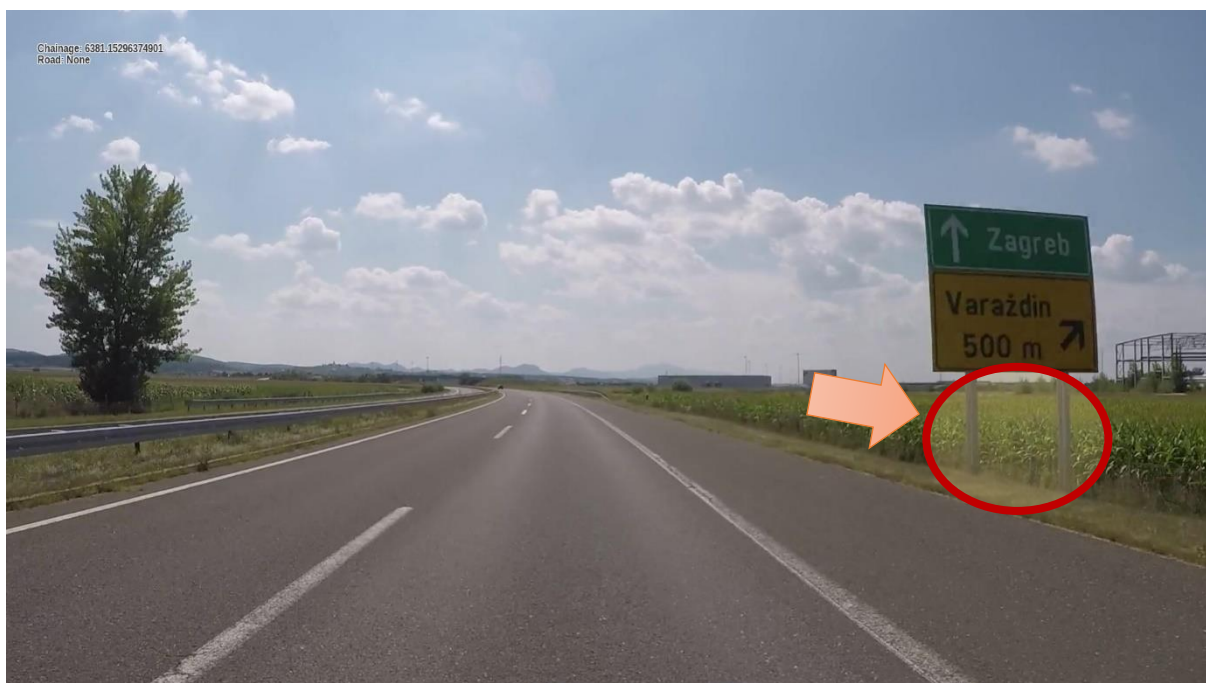
Slika 29. Primjer opasnog mjesta s nezaštićenim stupovima prometnog znaka na desnoj strani ceste, bez postavljene zaštitne odbojne ograde
