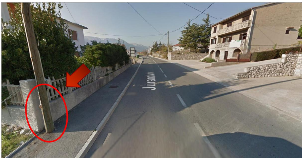
*Slika 19. Primjer opasnog mjesto s nezaštićenim betonskim stupom javne rasvjete*
