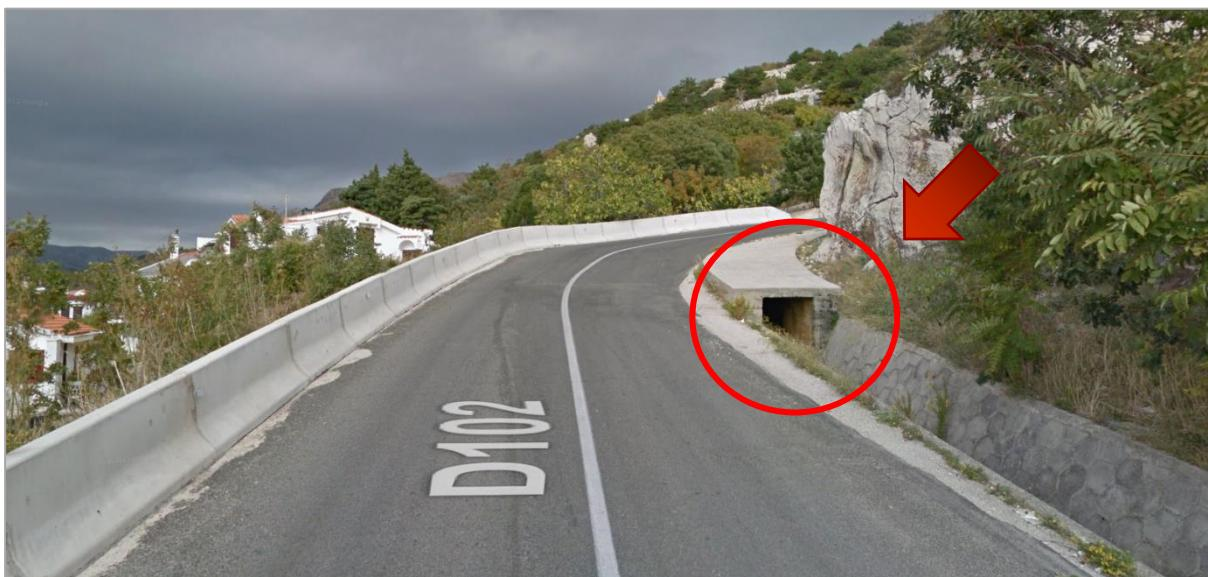
Slika 21. Primjer opasnog mesta s dubokim odvodnim kanalom i betonskim prijelaznim elementima uz cestu
