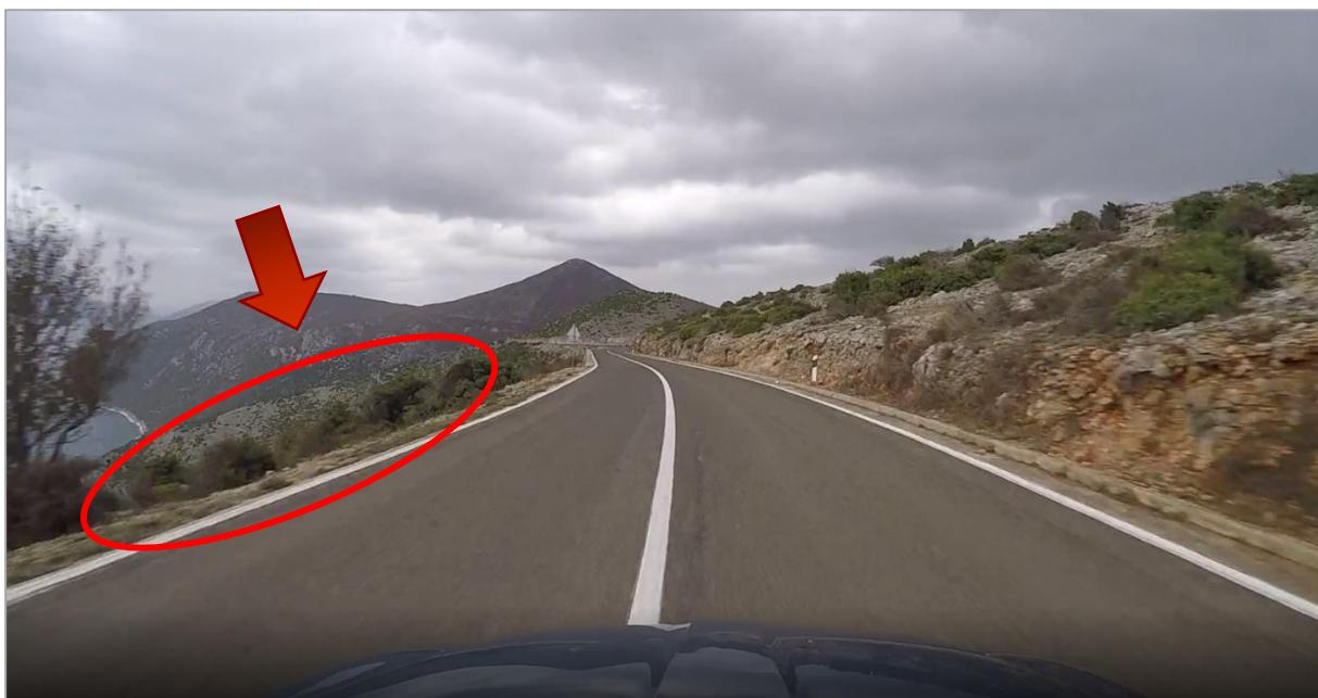
*Slika 32. Primjer opasnog mjeseta s provaljom na desnoj strani ceste, bez postavljene zaštitne odbojne ograde*
